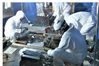
現場作業の状況
