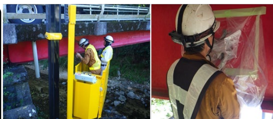
【塗膜サンプルの採取状況】
