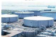
石油貯蔵タンク
