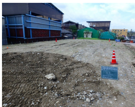
建設発生土の調査風景
