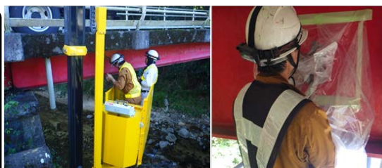
【塗膜サンプルの採取状況】
