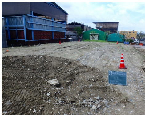
建設発生土の調査風景
