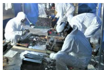
現場作業の状況
