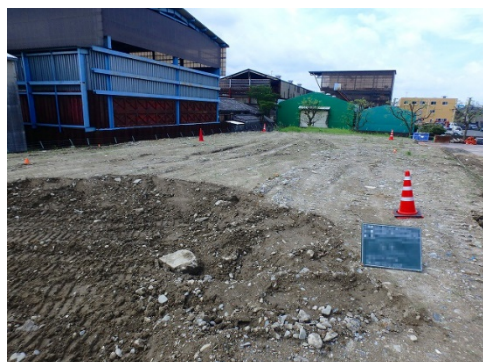
建設発生土の調査風景
